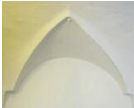
Das Gewölbe neben dem Pfarrbüro
